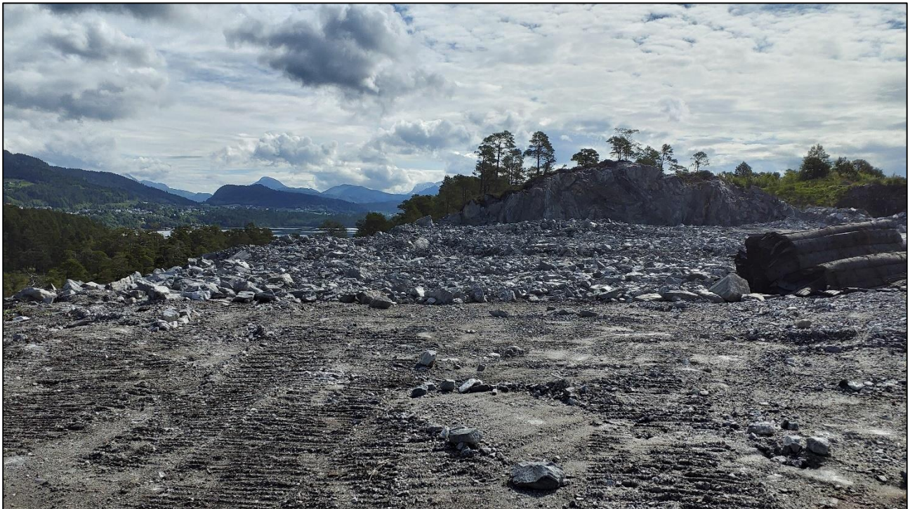
Figur 14: Registreringspunkt 599. Utsprengt flate.
