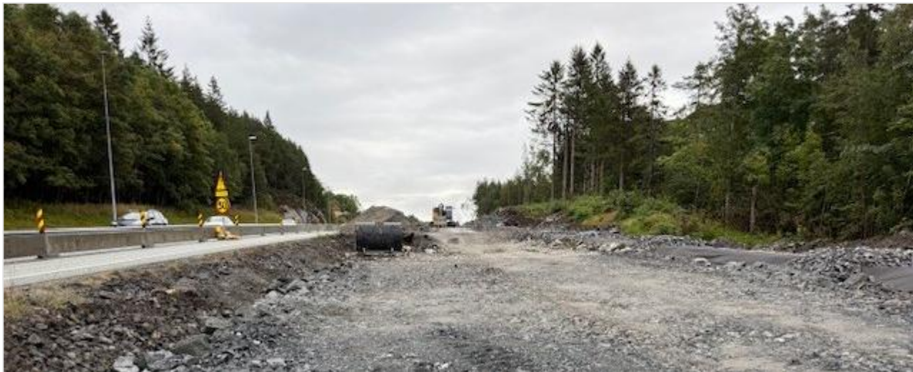
Figur 4-2: Foto av avskoget område på sørsiden av E136 (Foto: Norconsult).
