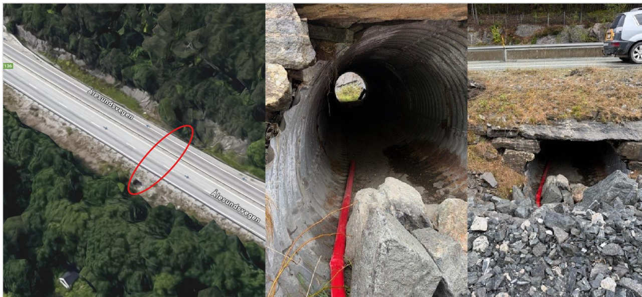
Figur 6-3: Lokasjon og foto av stikkrenna (Kilde: Google Maps og Norconsult).
