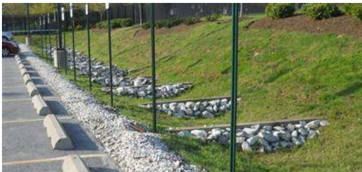
Figur 9: Eksempel på vadi med terskler hvor vannet holdes tilbake. Hentet fra Google bildesøk
