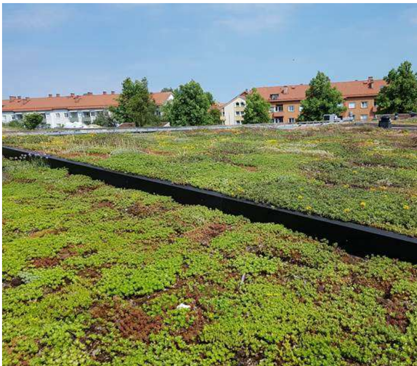
Figur 8: Grønt tak etablert på Scandinavian Green Roof Institute i Malmö, Sverige. Grønne tak kan også kombineres med fordrøyningsmagasin under jordlaget.
