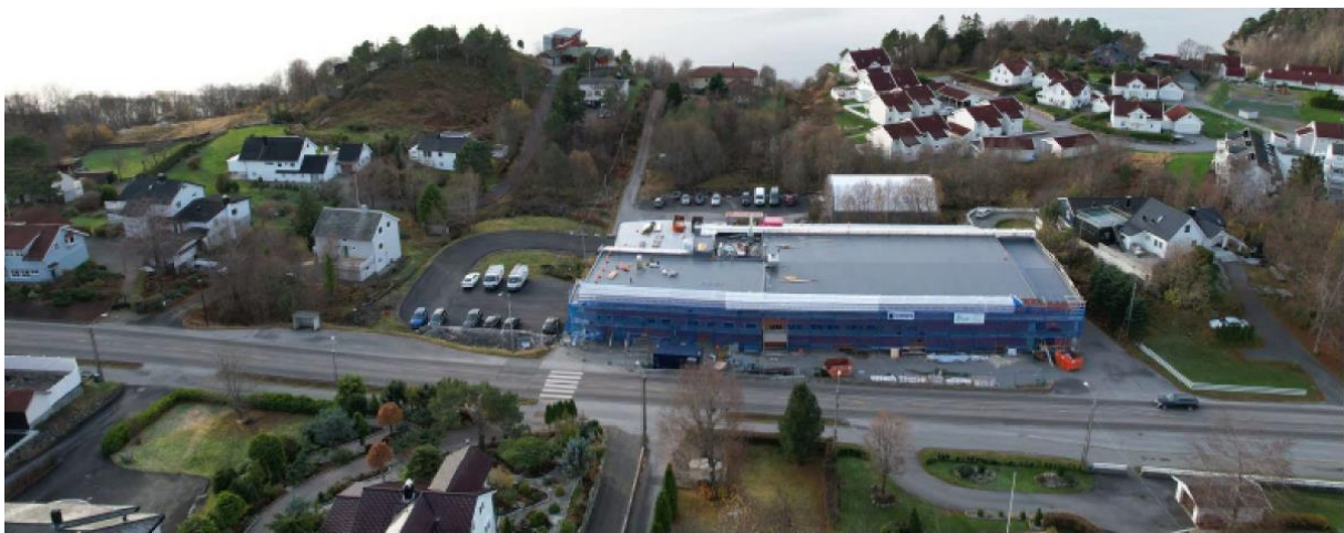
Figur 25. Spilka-eiendommen i eksisterende situasjon (08.11.2021).
