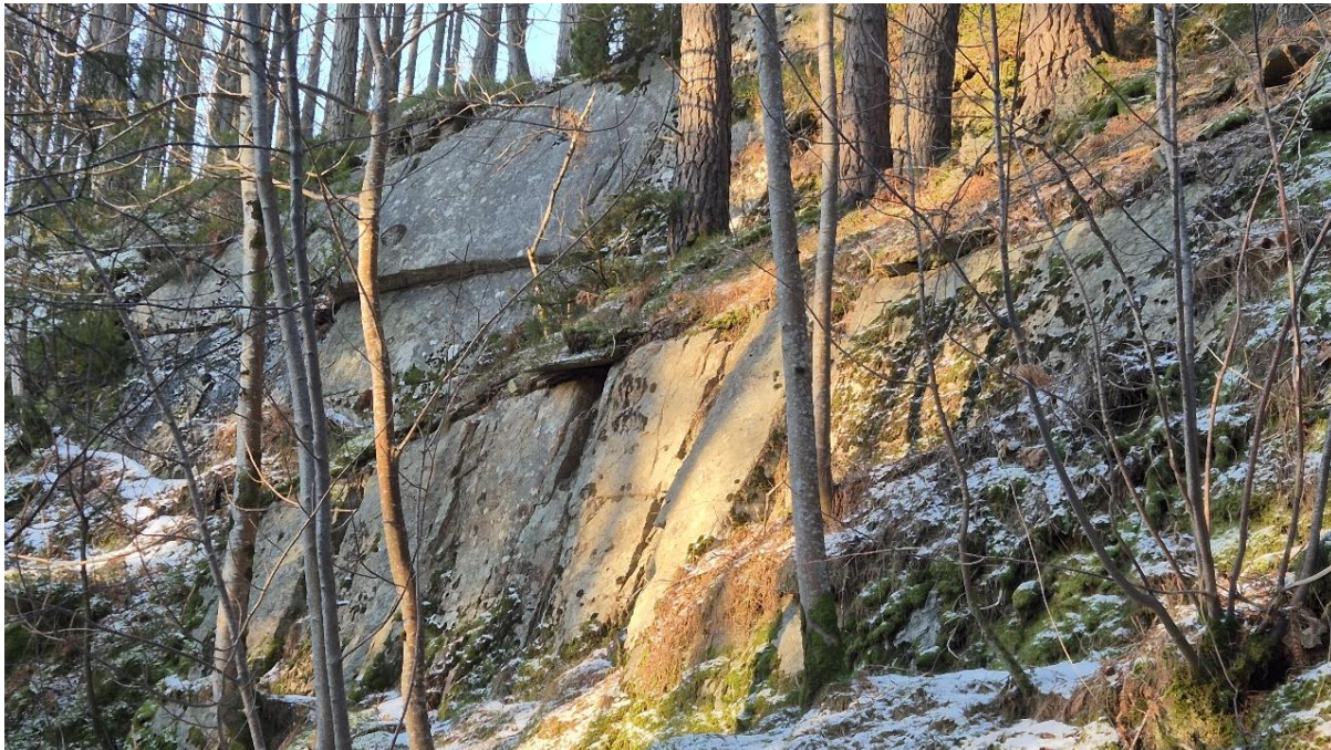
Figur 3 Bilete tatt ved punkt 11 viser noko oppsprukke bergmasse med teikn til flakdanning. Tidlegare utfall av steinsprang har stoppet ved foten.
