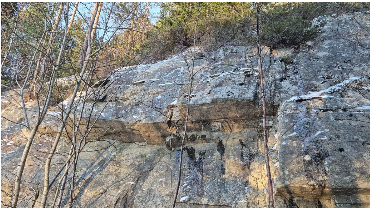
Figur 10 Bilete i punkt 20 viser blokk med open baksprekk ved eksisterande turveg. Losnesannsyn vurderast til 1/100. Blokk vil stoppe langs eksisterande turveg.
