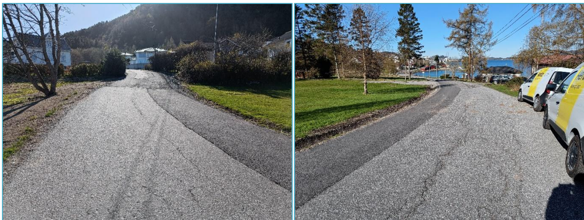
Bilete 3 Bilete av Østre Olsvikveg ved planlagt avkøyrsløse frå planområdet, som syner breiddeutviding av vegen. Foto: B. Friisvold
