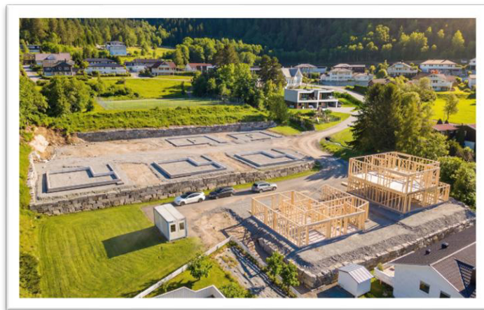
Innenfor planområdet er tomtene opparbeidet med natursteinsmurer. Disse tar opp høydeforskjellene, slik at boligene kan ha integrerte garasjer med enkel adkomst til stikkveiene.
