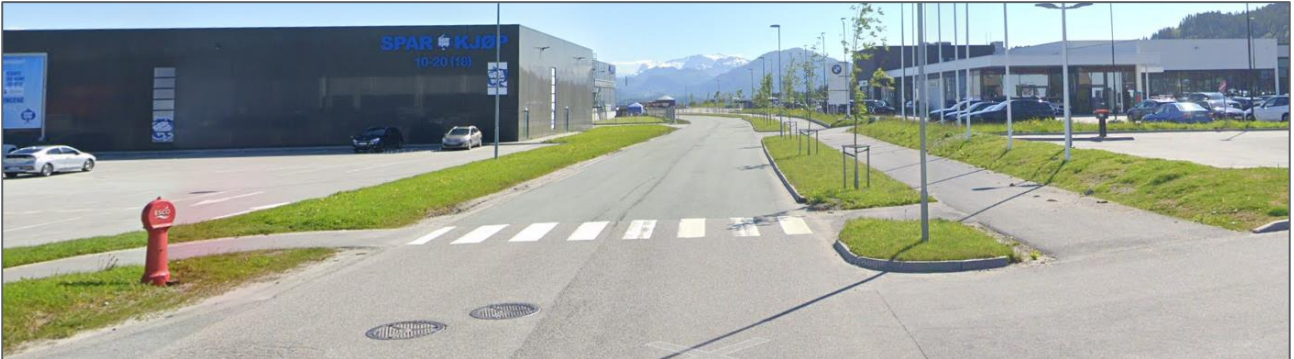
Figur 4: Kv. 52035 Digernes næringsområde sett mot øst fra avkjøring til bensinstasjon. Kun oppmerking av gangfeltet (ikke skilt), og generell belysning ved gangfeltet (Google Street View juni 2022)
