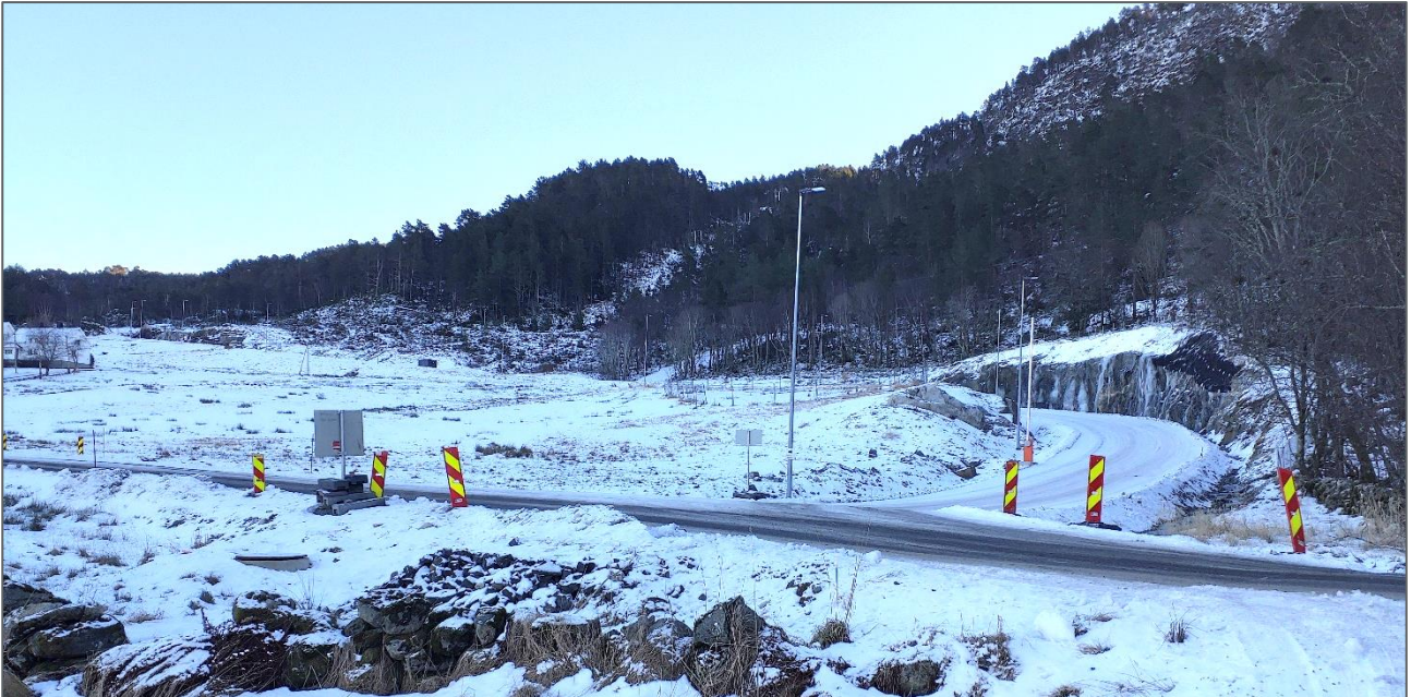
Figur 1: ID-punkt 1349. Fjellside til høyre i bildet (sør).
