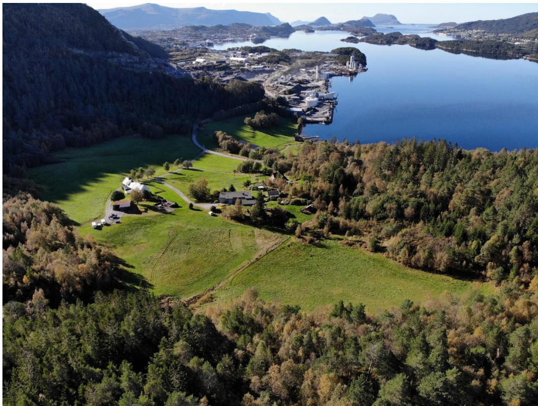
Figur 41 Dronebilde. Anleggsveggen skal gå helt i skogkanten til venstre i bildet. (foto: Alvika næringspark)
