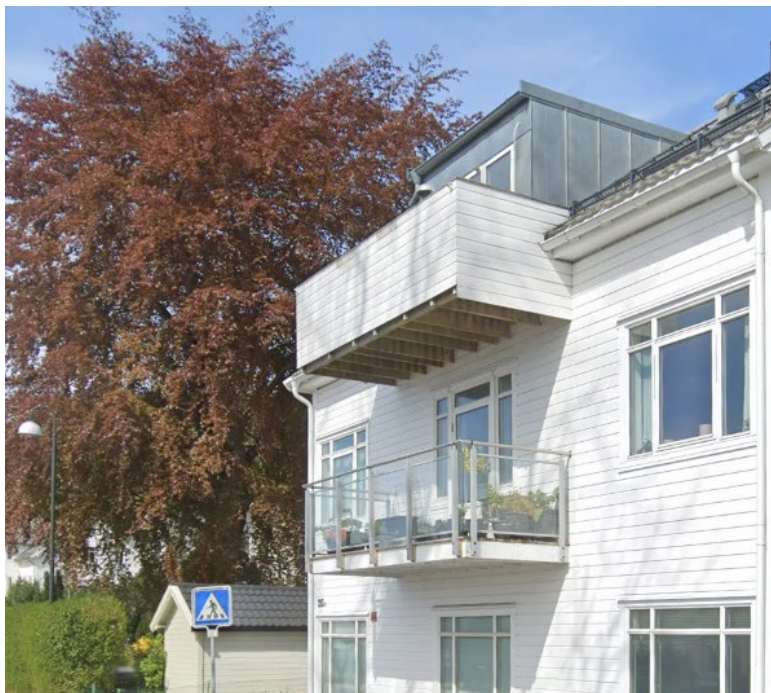
Figur 14: Bygg frå mellom 1930 og 1947.
