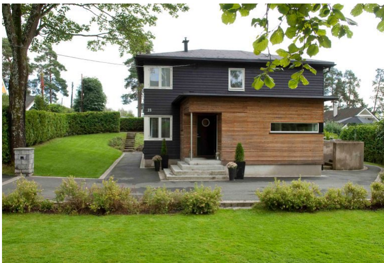
Figur 40 til venstre: Ruglandveien 25 på Jar, Oslo, teikna av arkitekt Jan Stensrud. Bilde henta frå www.dibk.no .
