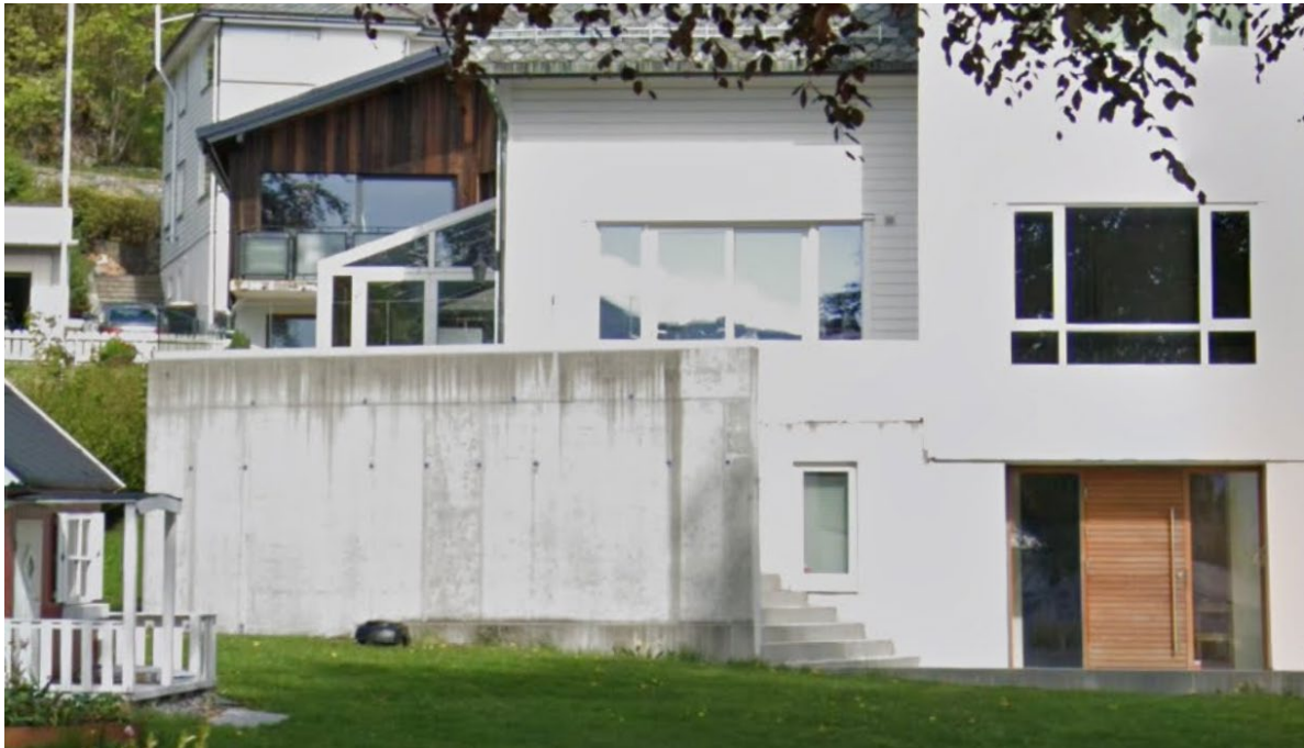
Figur 15: Modernisering av bygg frå tidleg 1900-talet.
