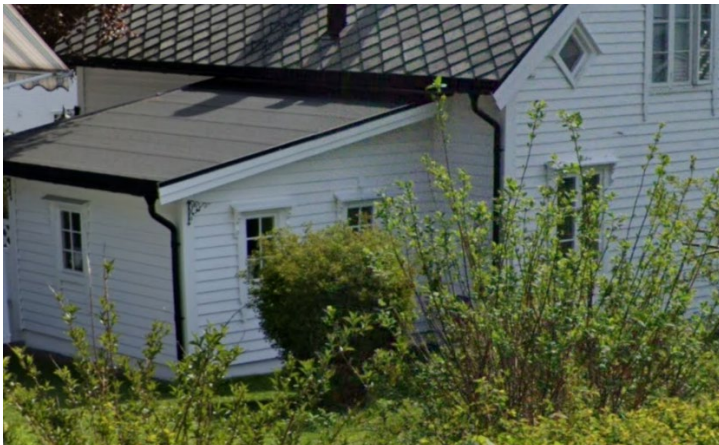
Figur 17: Tilbygg på baksida av bygget.
