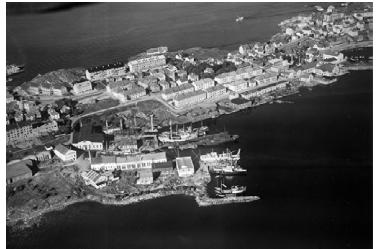
Foto fra Widerøearkivet, tatt på 1950-tallet, viser industriområdet med verft og pakkhus på rad og rekke langs sjøkanten, og arbeiderboliger mellom industriområdet og trebyen, og mellom denne og haugene nord på øya. Bilen hadde ennå ikke blitt allemannseie, og det var viktig å bo så nære arbeidsplassen som mulig.
