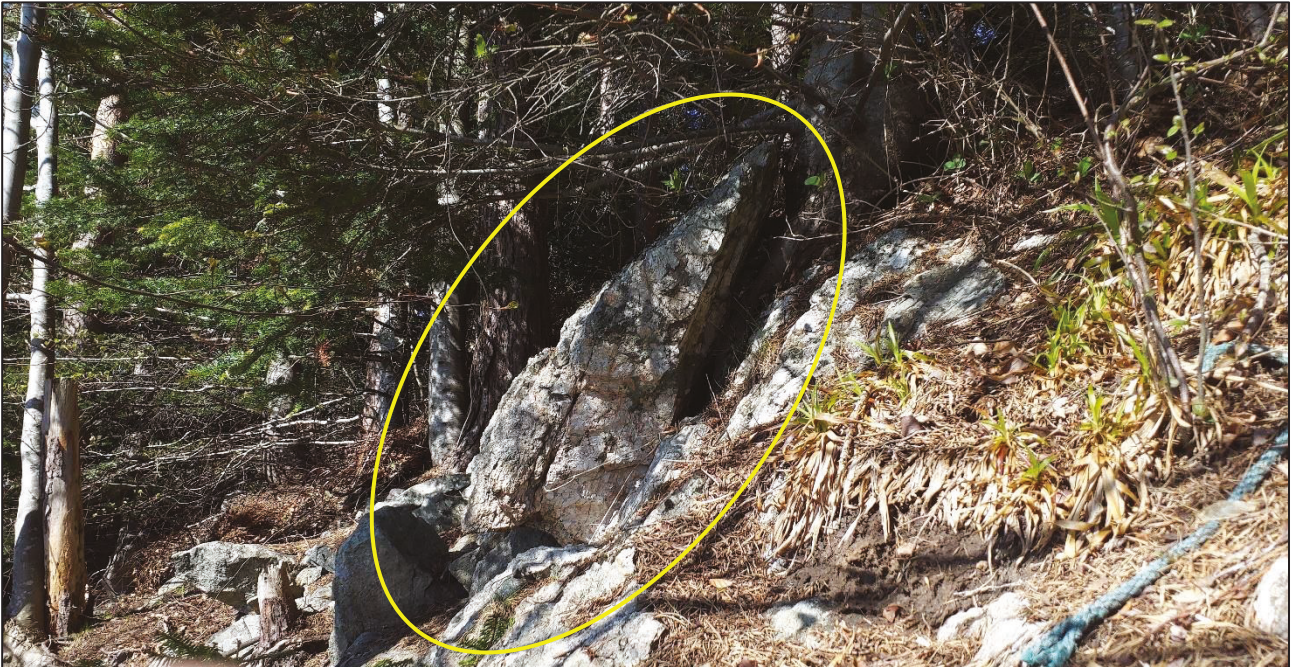
Figur 13: Observasjons-punkt 1101. Sprekkeavløst blokk som ligger stabilt.
