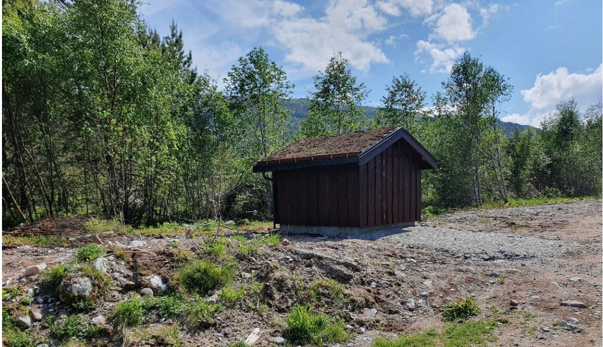
Figur 42: En ny privat pumpestasjon har medført fjerning av vegetasjon.
