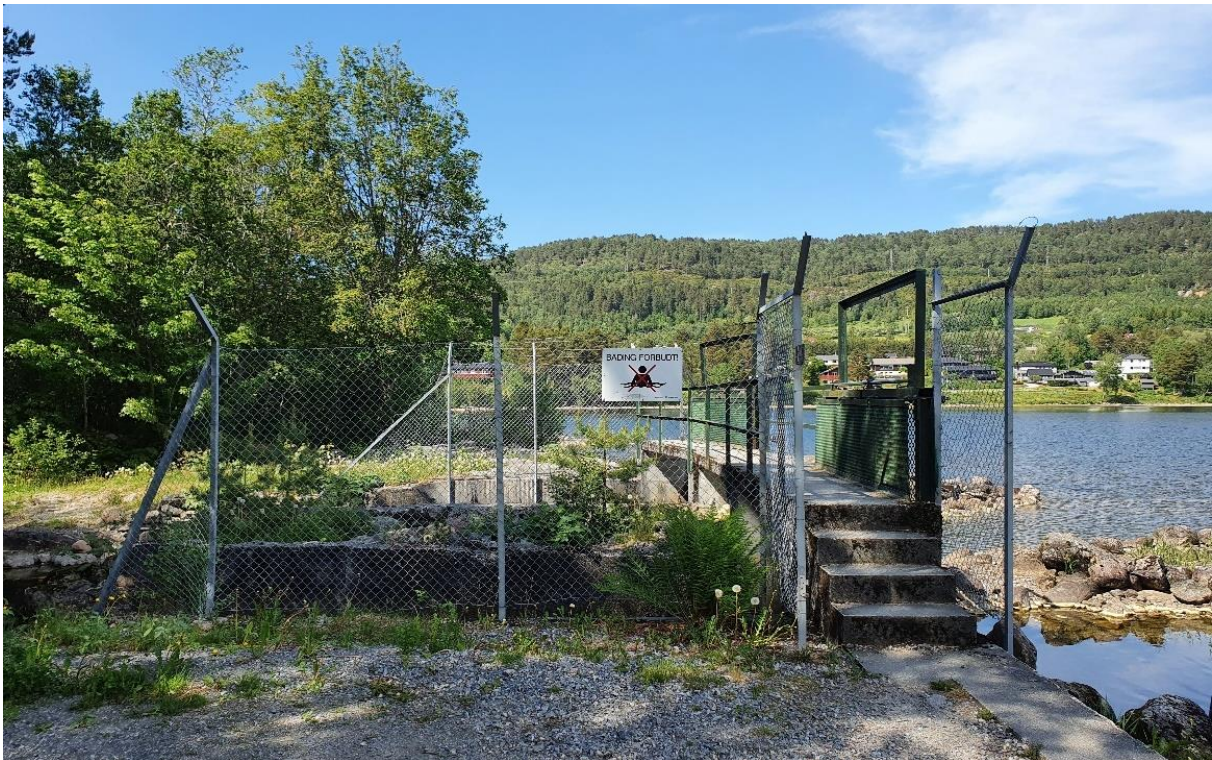
Figur 40: Tilrettelagt ferdsel over damanlegget.
