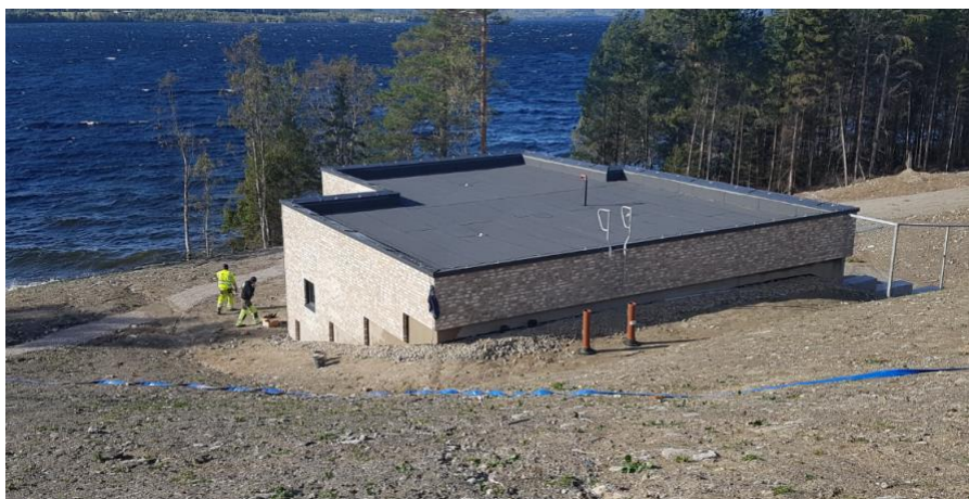
Figur 8 – Eksempel råvannspumpestasjon Hurdalssjøen VBA
