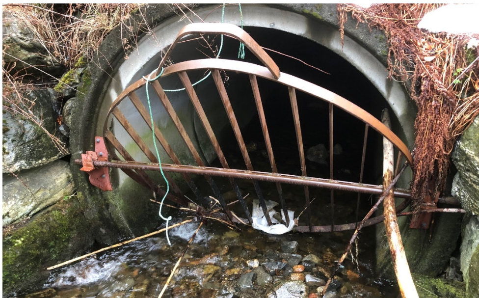
Figur 7-3 Innløp av kulvert i Wensselelva
