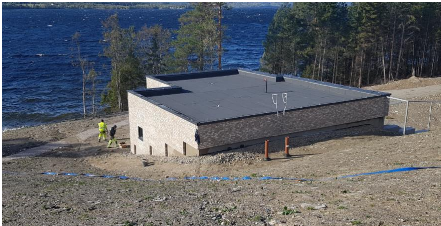
Figur 8 – Eksempel råvannspumpestasjon Hurdalssjøen VBA
