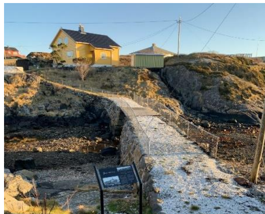
Gamlebrua mellom Ona og Husøya
