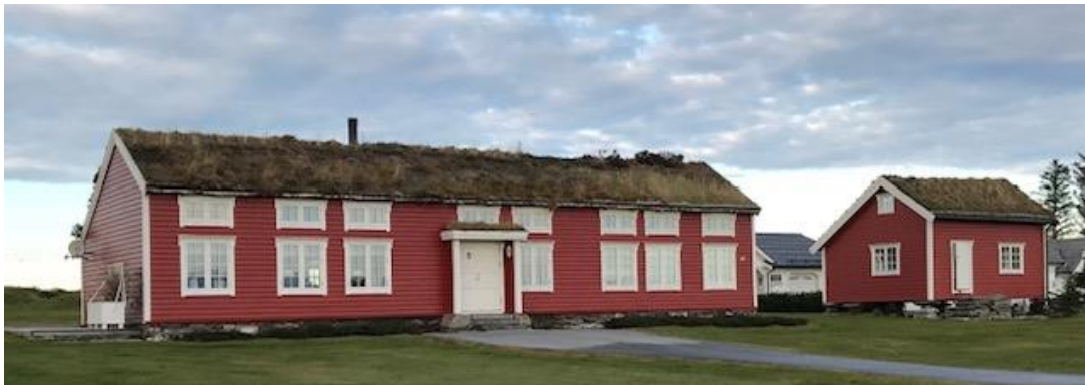
Våningshuset på Gjerdet, restaurert av Knut Sæterøy og Synnøve Austnes
