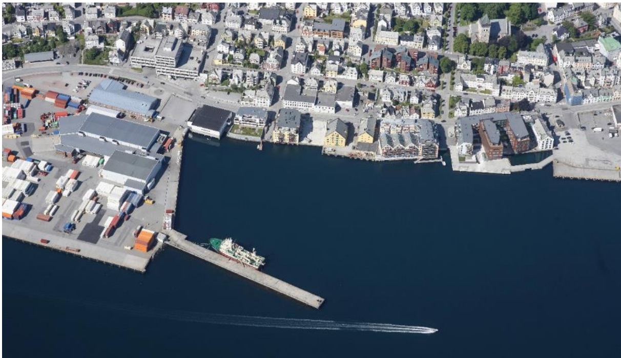
Figur 4-11: Boligutvikling på tidligere næringsareal ved sjøen øst for Skutvika, Politihuset oppe til venstre (Blom)
