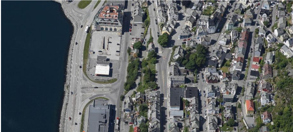
Figur 4-15: Fra Ysteneset mot vest. Sentrumsbebyggelse med vesentlig boliginnslag i høyreliggende gater og større næringsbygg og transformert industri på utfylte masser ved E136 og Ystenesegata/Sundgata (1881.no)
