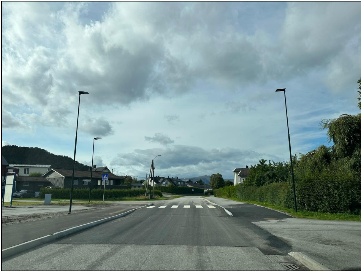
Figur 54 Bildet viser fortau og et lyssatt overgangsfelt over Vasstrandvegen, like sør-vest for utbyggingsområdet.
