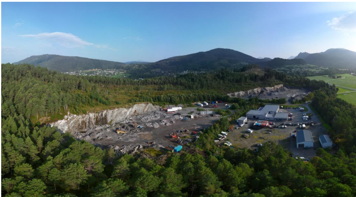
Figur 13: Dronefoto av planområdet. Området der hydrogenanlegget skal etableres er sprengt ut og opparbeidet (til venstre på bildet). Kilde: Norconsult Norge AS.
