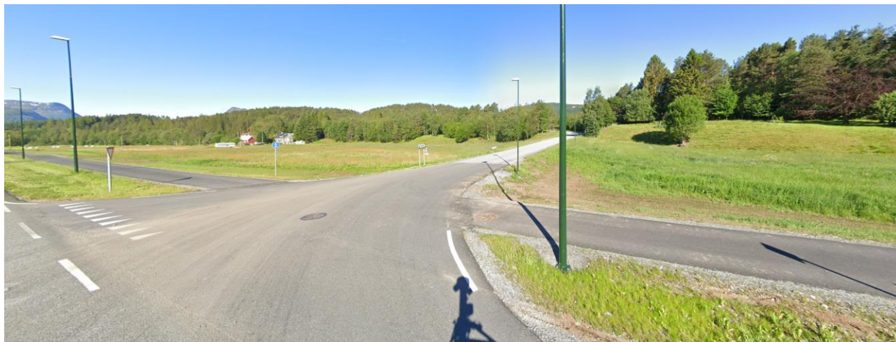
Figur 4: Krysset fra Storfjordvegen og oppover Ole Dreng-vegen.
