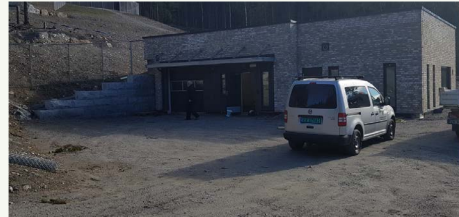
Råvannspumpestasjon Hurdalssjøen VBA
