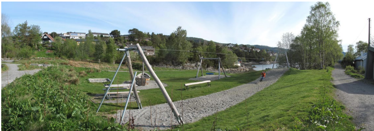
Skråvika, blikk fra området ved pumpestasjon mot nordøst. Badevika i bakgrunnen.
