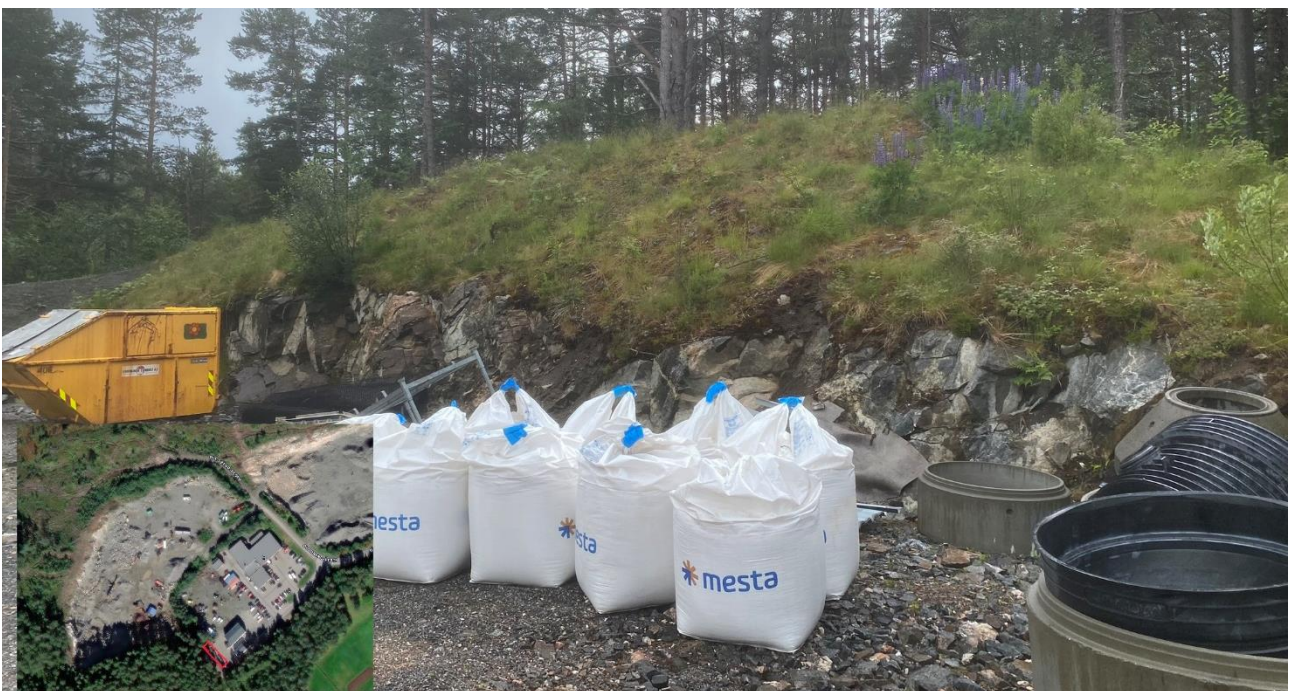
Figur 7. Fjellskjæring sørøst for tomten. Oversiktsbilde nede til venstre viser med rød avmerking hvor bildet er tatt.
