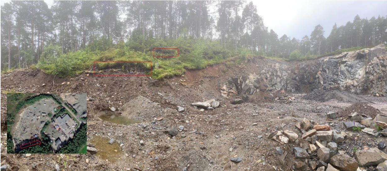
Figur 6. Fjellskjæring og knauser sør og vest for tomten. Oversiktsbilde nede til venstre viser med rød avmerking hvor bildet er tatt.
