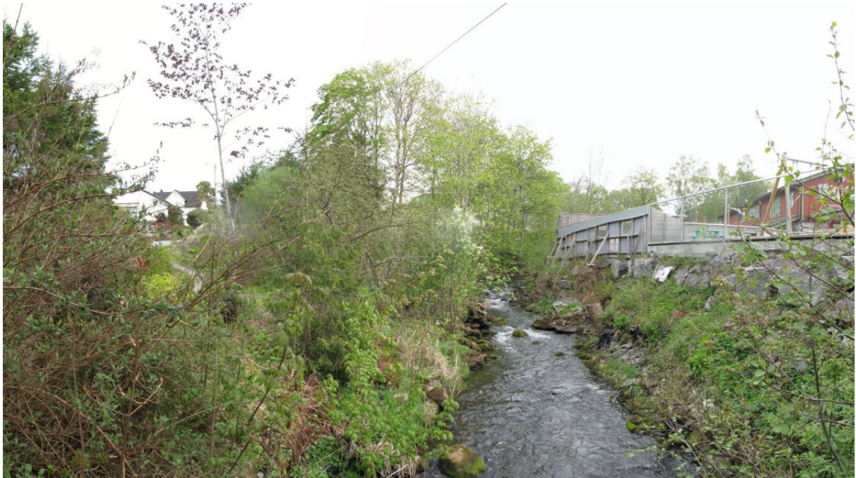
Elva nord for brua som skal byttast ut.
