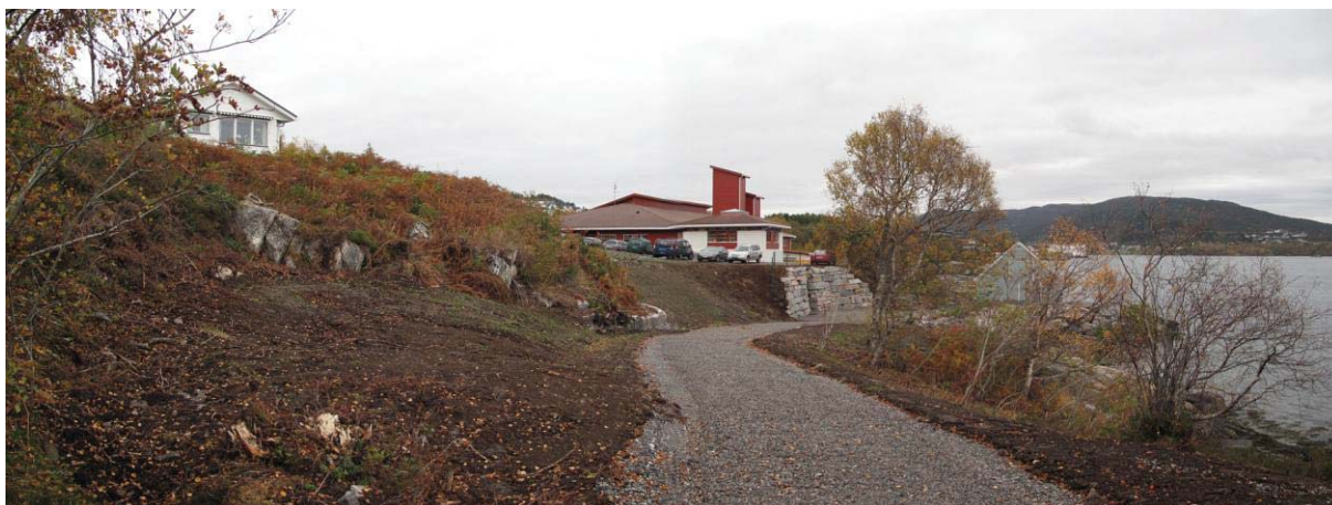
Figur 5: ferdig turveg vest for renseanlegget på Åse (Foto: Arne Neumann, ÅK)
