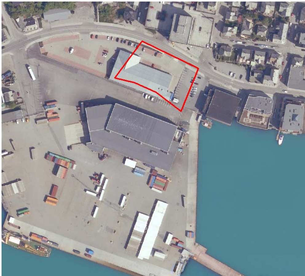
Figur 2-1 Omtrentlig plassering av tidligere Florvåg verft i Skutvika. Nøyaktig plassering og omfang er ikke kjent. Figur hentet fra Multiconsult rapport nr 413759 -2, november 2010. Eldre flyfoto over området er nå lagt ut på kartserver til Ålesund kommune, og plasseringen kan bestemmes mer nøyaktig. Se Figur 2 og Figur 3
